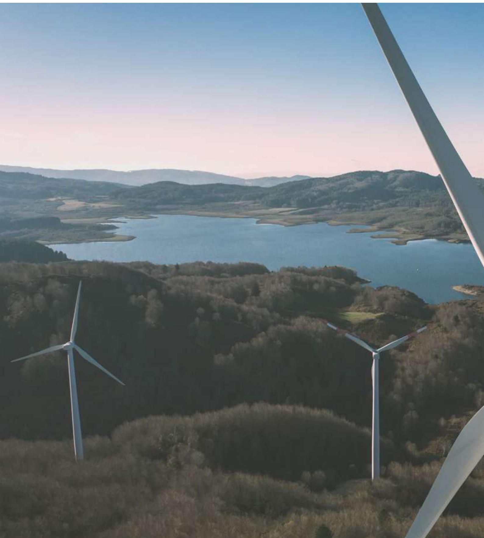
Impianto eolico di San Sostene (CZ).
